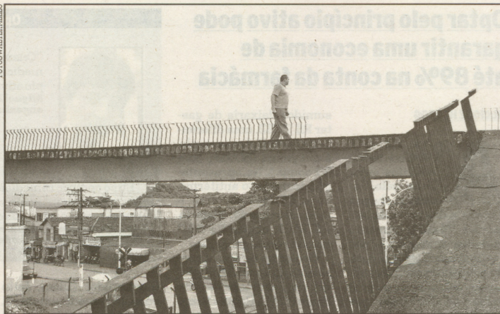
A passarela próxima à Estação das Barcas oferece risco de morte a quem se arrisca a passar por ela
